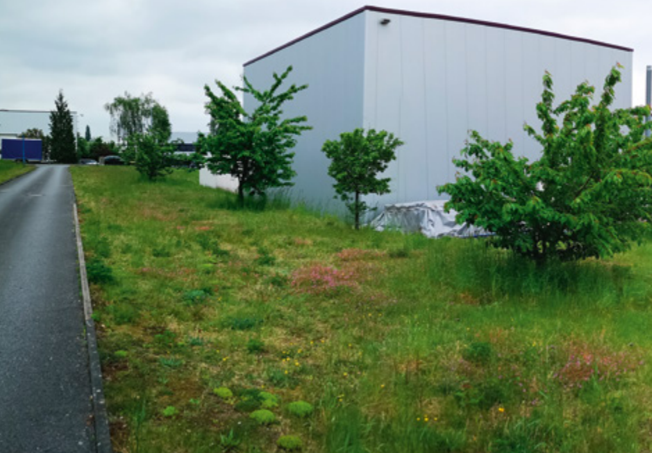
Auch ein Weg: Man überlässt das Außengelände weitgehend sich selbst.
